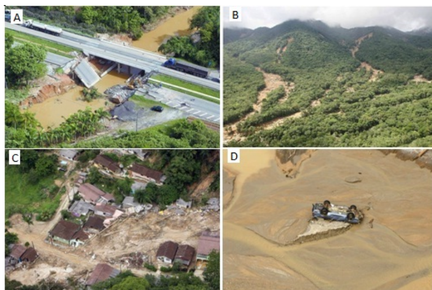
Figura – 3: A, ponte destruída na BR-277; B, escorregamentos translacionais e fluxo de detritos a montante da comunidade de Floresta (Morretes); C, destruição causada por escorregamento no bairro Laranjeiras em Antonina; D, sedimento acumulado sobre a comunidade rural de Floresta, Morretes. Fotos: Gazeta do Povo, 11 de março de 2011.
